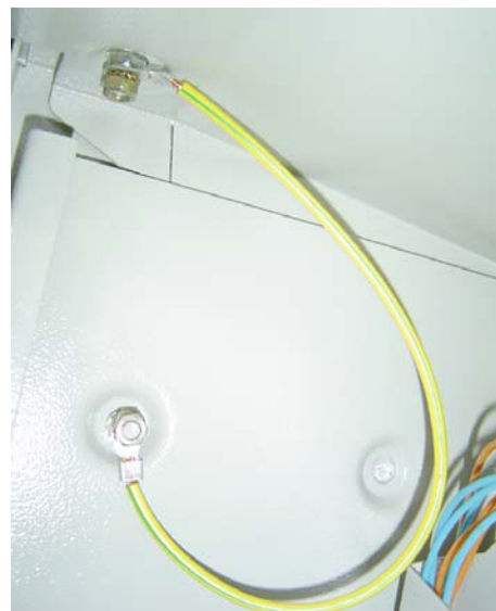
Connection de la masse Porte OPERATEUR / COFFRET
