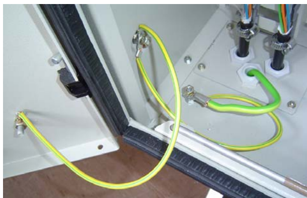
Connection de la masse Porte PROPRIETAIRE / COFFRET
