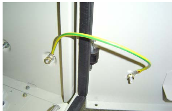
Connection de la masse Porte OPERATEUR / COFFRET
